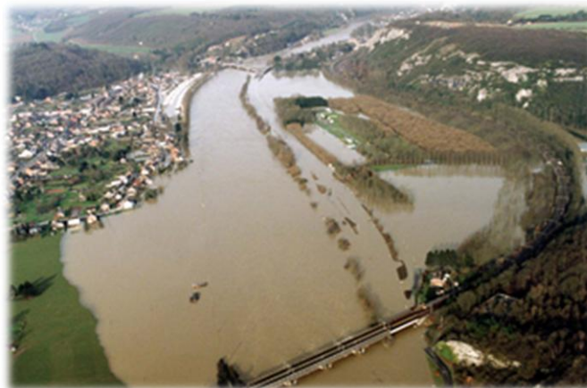
Inondation par débordement de cours d'eau Source : SPW/DGO3/DCENN
